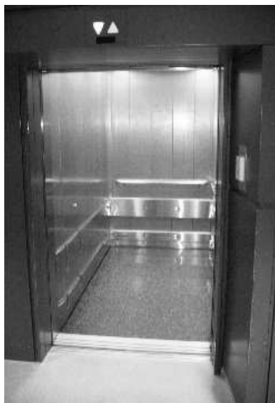
Abb. 11: Bettenaufzug vor der Intensivstation 19 A Ost im UKM
